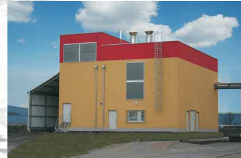
Ein Pflanzenöl-BHKW mit 2 x 854kW und integriertem Tanklager
