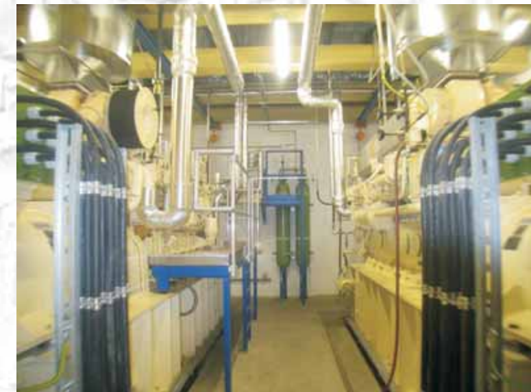
zwei 854kW-Motoren laufen um die Wette, 8.500h im Jahr...
