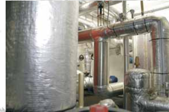
Auch in Kraftwerken muss ordentlich isoliert werden, nur das bringt Wirkungsgrade
