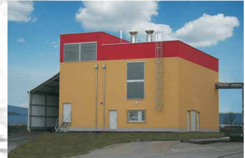
Ein Pflanzenöl-BHKW mit 2 x 854kW und integriertem Tanklager
